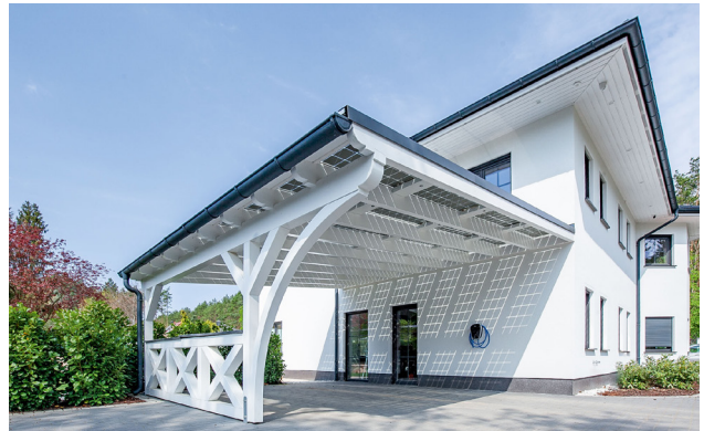
Jeder Solarcarport wird passend zum Eigenheim geplant und fachgerecht errichtet.
